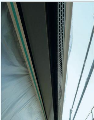
Lüftungsgitter sichern den Hinterlüftungsraum und werden ab einer Öffnungsbreite über 20 mm gefordert.
